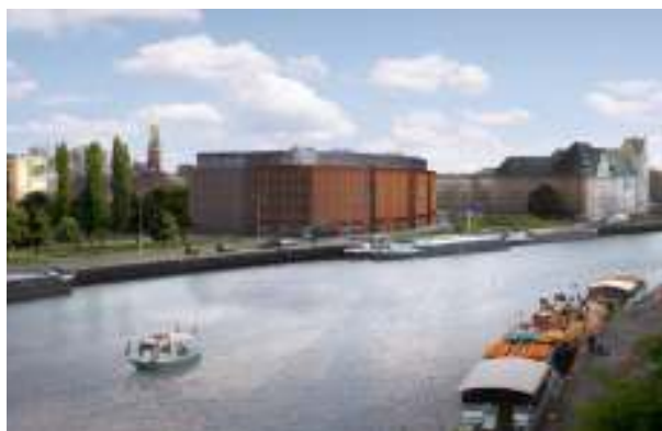
SGI BALTIS - BUDOWA BIUROWCA RIVER BUSINESS CENTER
