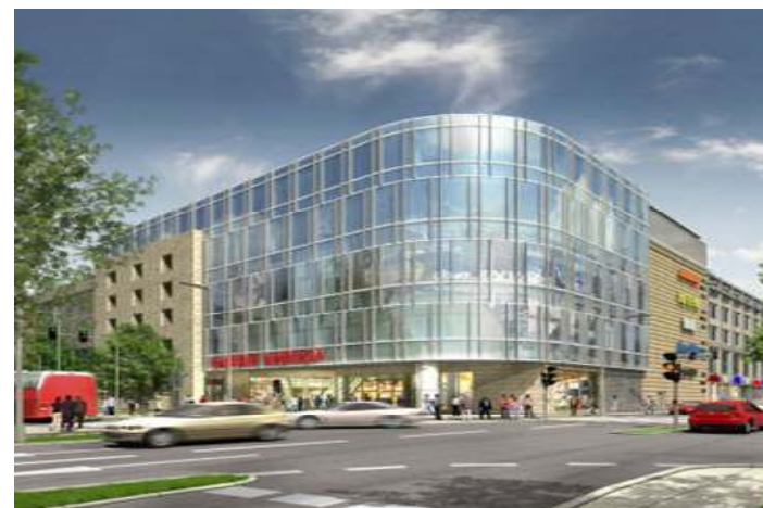
ECE – REALIZOWANE CENTRUM HANDLOWE KASKADA
